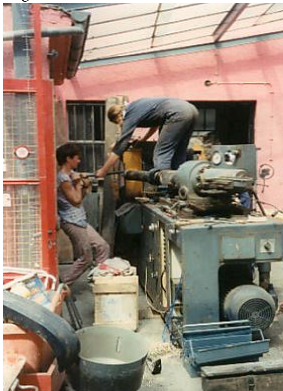
Maschineninstandsetzung für Firma CONIPLAS/Nicaragua. Die Maschinen wurde vor Ort im Rahmen eines Betriebspraktikums durch Werkhof-Azubis installiert und in Betrieb genommen (1989).
