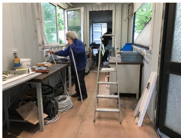
Die Einrichtung der Werkstätten und die Elektroinstallation gehen voran
