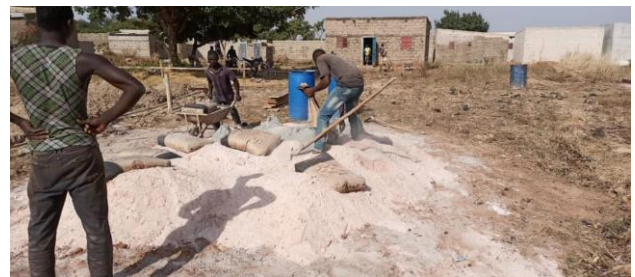
Erste Vorarbeiten auf dem neuen Terrain im Secteur 33
